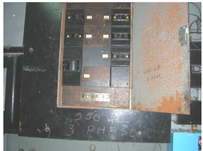
Fig. 2.5.1 Corroded 480 volt electrical panel.
